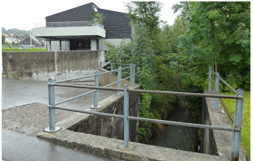
Abb. 9 Einlauf Eindolung Bleichenwäldlibach (von Sitterstrasse in Richtung Militärunterkunft fotografiert)
