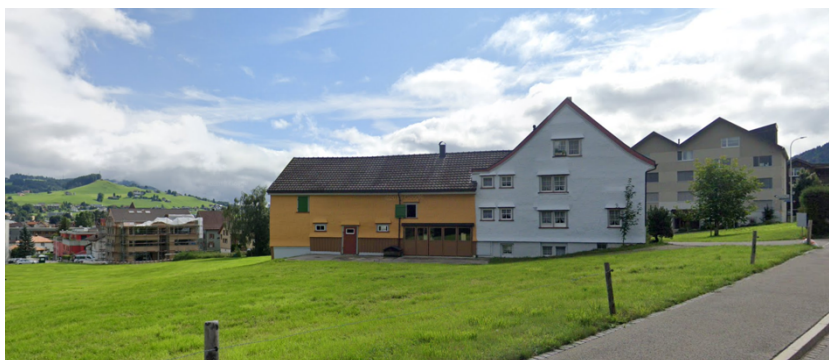
Abb. 31 Beispiel einer an die Siedlung angrenzenden Stammliegenschaft entlang der Kaustrasse, StreetView (August 2019)
