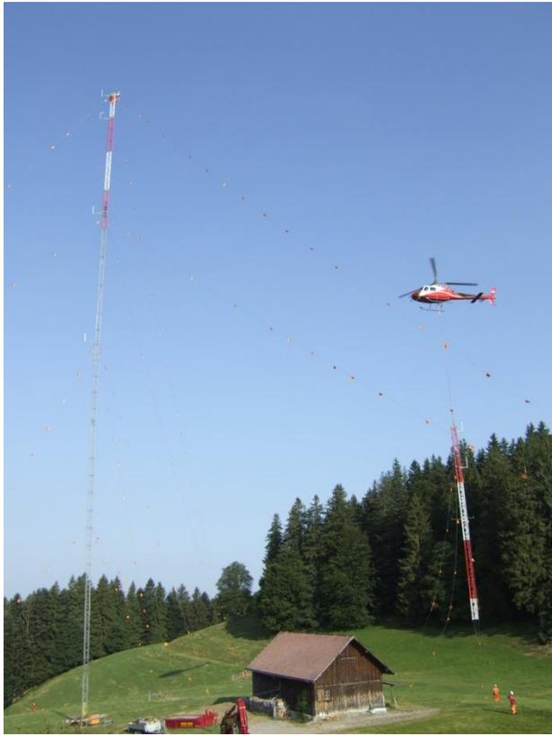
Abbildung 3: Foto Messmast beim Aufbau
