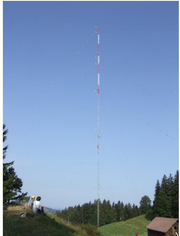
Abbildung 4: Foto Blick auf den Mast
