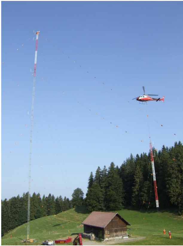
Abbildung 3: Foto Messmast beim Aufbau
