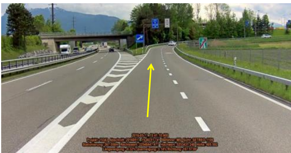
1. Ausfahrt A13\ AS 2-Au Abfahrt zur Zollstraße aus Richtung St.-Gallen kommend.
