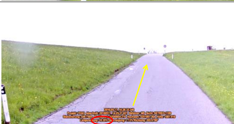
47d. St.Antonstrasse Straßenschäden
