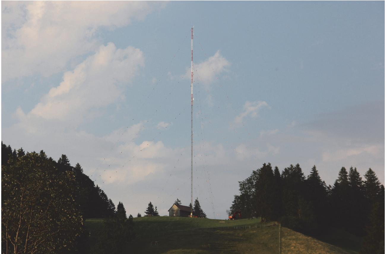
Abb. 12 Windmessmast am Standort, mit Markierungen gemäss BAZL, Blickrichtung Norden
