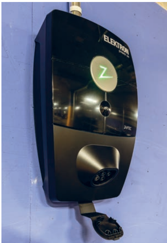
Abbildung 1: Die in der Tiefgarage Klee realisierten Ladestationen stammen von der norwegischen Firma «Zaptec». Sie liefern eine Leistung von 22 kW und verfügen über einen eingebauten Stromzähler, der eine genaue Verbrauchsmessung und damit auch eine individuelle Abrechnung ermöglicht. Der Zap-Charger Pro ist eine Wechselstrom-Ladestation mit Typ-2-Ladestecker. Er kann an der Wand oder als Ladesäule installiert werden ( www.zaptec.com )
