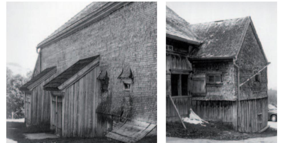
Der Stall übernimmt die Proportionen der traditionellen Appenzeller Gaden. Besonderes Augenmerk wird dabei dem Verhältnis zwischen Wand und Giebfeld geschenkt. Der First wird leicht aus der Mitte gerückt, die Dachneigung entspricht der appenzellischen Bauweise.
