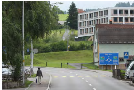
Der alte Verlauf der Gaiserstrasse ist nur noch zu erahnen. Die neue Wegführung dient den Autos, aber verunklärt das Verständnis des Ortes.
