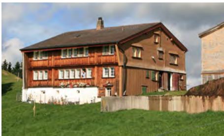
Heidenhaus: Stubenfassade zur Traufseite, mit Tätschdach in Getrenntbauweise. Tritt ein Gaden dazu, verlängert er das Haus in Firstrichtung.
