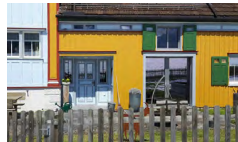
Nutzungsbedingte Umbauten lassen sich an der Fassade ablesen.
