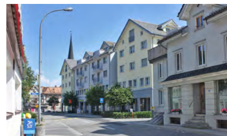
Das Ladenzentrum Oberegg belebt den Strassenraum, verfehlt aber den Massstab des Dorfs.
