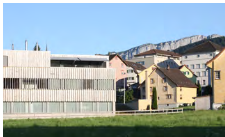
Gute Details und heimisches Material – dennoch bildet der Neubau mit seiner Umgebung keine Ganzheit.
