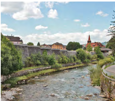
Wegeverbindung längs der Sitter in Appenzell. Die Friedhofsmauer prägt den Flussraum hart.
