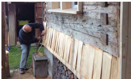
2014: Die Hütte der Alp »Oberer Orlehan« wird neu geschindelt ( www.handfactory.ch ).
