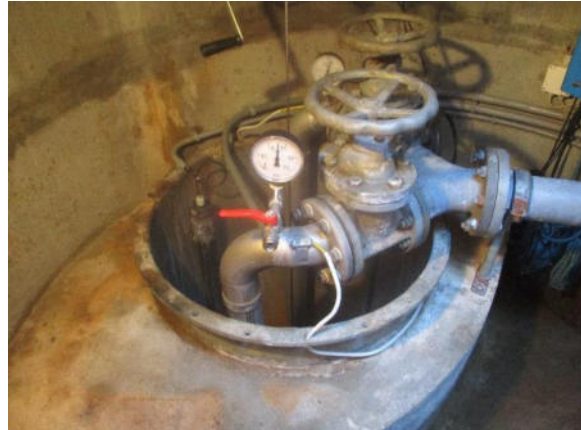
Abb. 3.2: OK Filterbrunnen mit Pumpen (Foto L&H: 17.2.2021)
