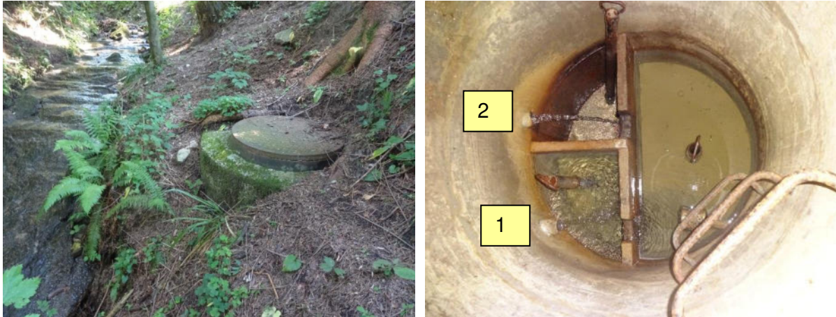
Abb. Nr. 3.1 und 3.2: Quellschacht Torfnest 35
