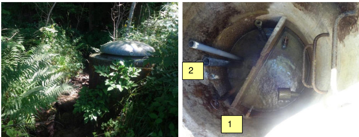
Abb. Nr. 3.3 und 3.4: Quellschacht Torfnest 36
