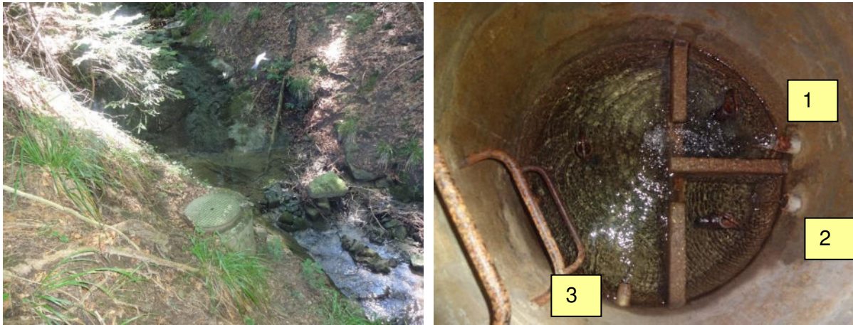
Abb. Nr. 3.5 und 3.6: Quellschacht Torfnest 38
