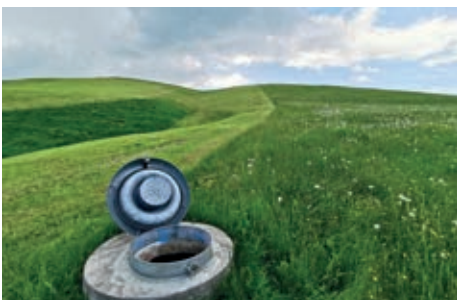
Brunnenstube im Bensol
