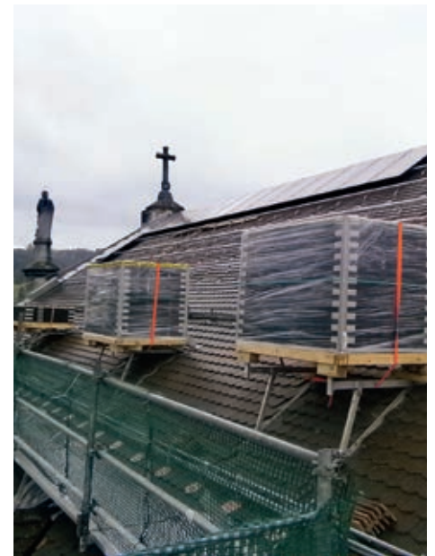
Montage der PV Anlage auf das denkmalgeschützte Objekt.
