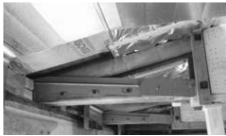
Auflage Verstärkung (unten) Zusätzliche Balken
