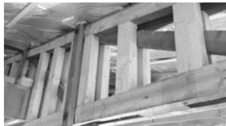
Auflage Verstärkung (unten) Zusätzliche Balken
