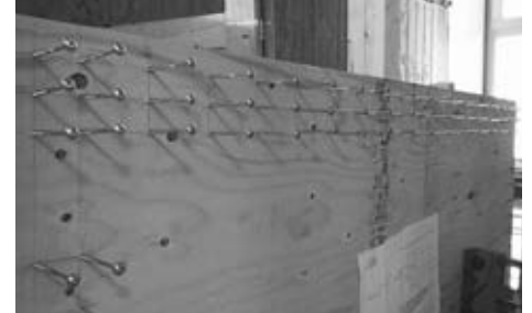
Verschrauben und verleimen mit querverleimten Platten
