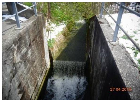
Einlaufbauwerk/ Absturz Bleichenwäldlibach
