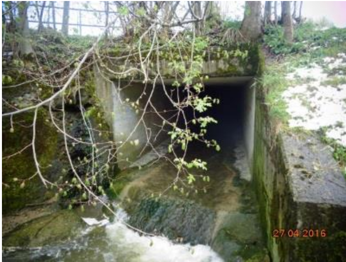
Auslauf bestehende Eindolung Bleichenwäldlibach
