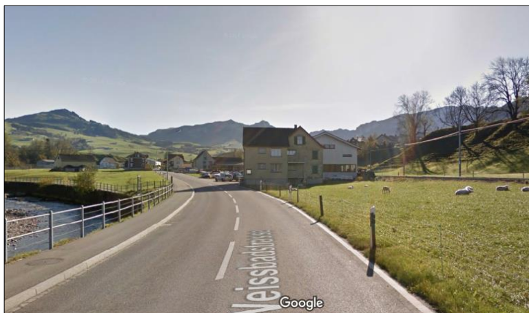
Quelle: google Street View - Okt. 2014
